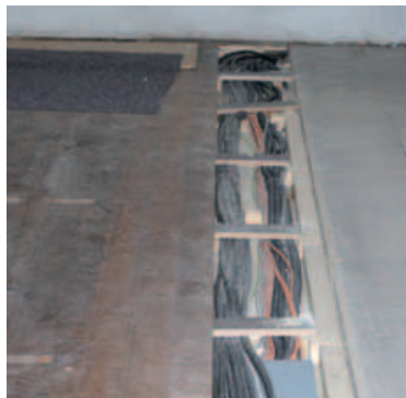
unter dem alten Boden und hinter den alten Wänden verbirgt sich jetzt neue Elektrik
