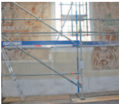
Restaurierung der Wandmalereien
